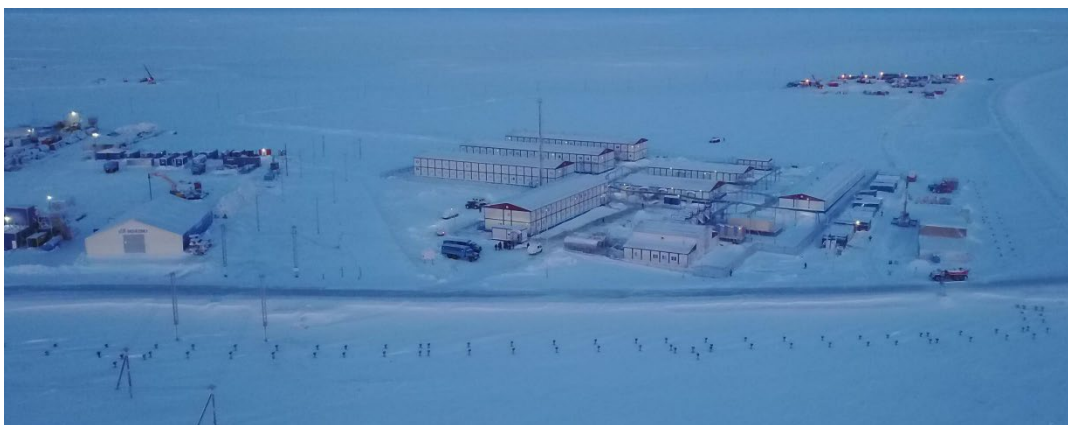
Лакокрасочное покрытие ИЗОЛЭП-mastic защищает сваи объектов проекта «Арктик СПГ 2» ПАО «НОВАТЭК»
