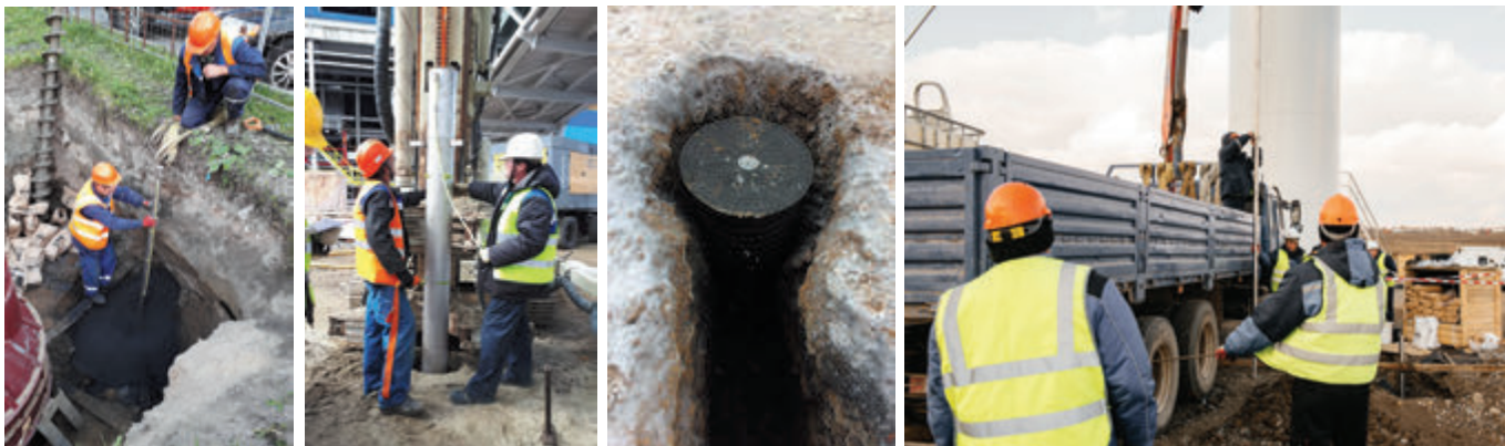
Фото 1-4. Шефмонтажные работы на объектах
