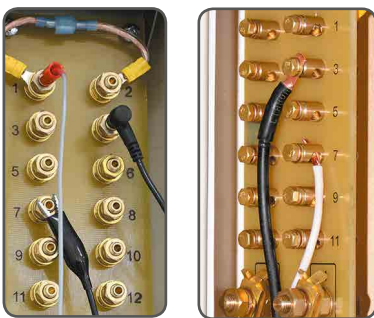
Вид клеммной панели КИП ХС с лицевой и монтажной стороны
